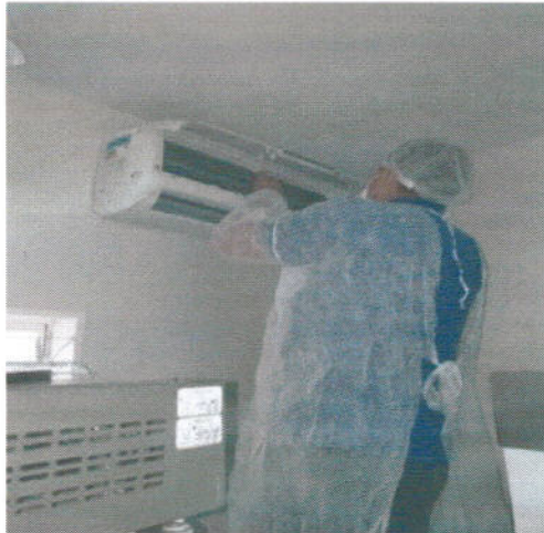
Figura 1 . Manutenção Ar condicionado
