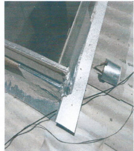
Figura 2. Troca de telhas
