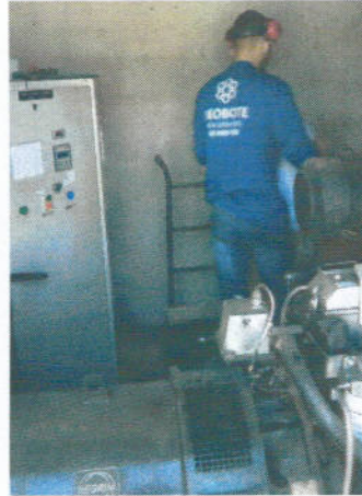
Figura 3. Manutenção Gerador - REOBOTE
