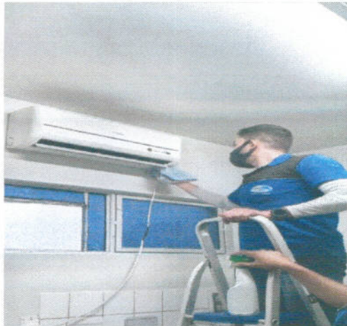
Figura 1. Manutenção ar condicionado
